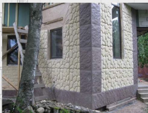
СТЕНЫ ИЗ ГАЗОБЕТОНА
