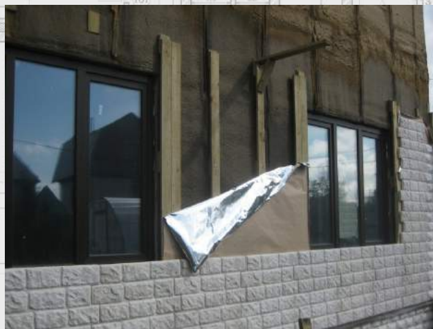
УСТРОЙСТВО ОБЛИЦОВКИ ИЗ ЛКП
